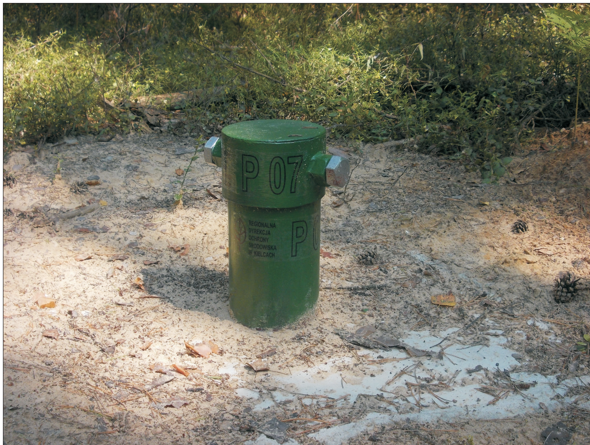
Fot. 09. Piezometr P 07, (R. Spiżewski).
