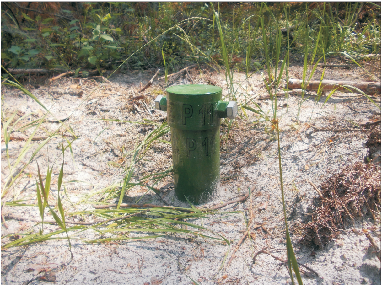
Fot. 12. Piezometr P 12, odwiercony przy nowej drodze leśnej , (R. Spiżewski).
