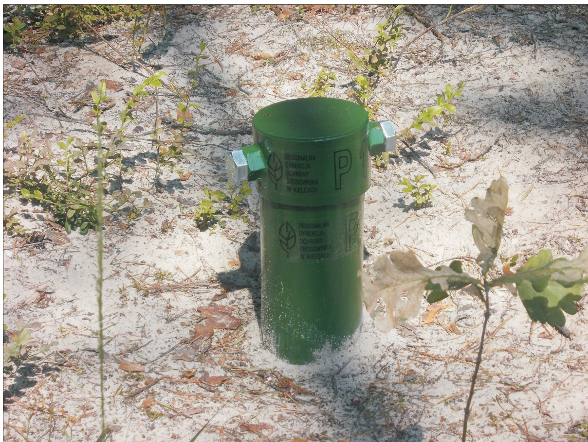
Fot. 10. Piezometr P 10, (R. Spiżewski).
