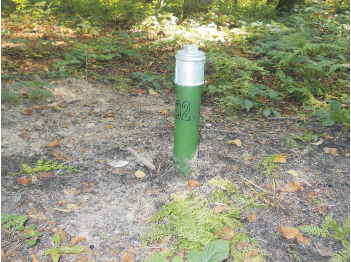
Fot. 05. Piezometr P 02 w północno - zachodniej części rezerwatu, przy rowie zachodnim, (R. Spiżewski).
